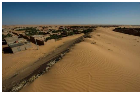
Fig.02 : système de (palissade) pour la lutte contre l'ensablement devenu inopérant face à la grandeur du phénomène. A droite de la dune l'ancien ksar de Badrienne déserté. A gauche c'est la nouvelle agglomération.
