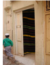
III n°6 : Ghardaïa : Confort d'hiver : Action d'adaptation anticipative : Un écran épais à l'entrée de la maison, (Source : O Douag)
