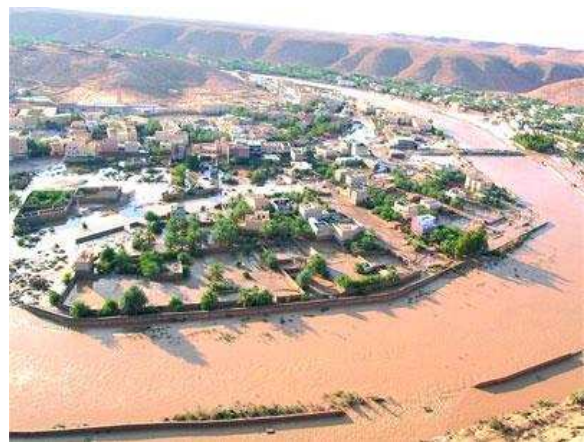
vallée du M'Zab 31 morts, 50 blessés, la destruction de 300 à 500 maisons et généré des milliers de sans abri, évènement illustré ci dessus.
